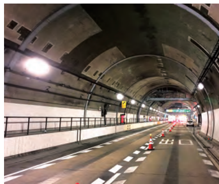
トンネル導水
