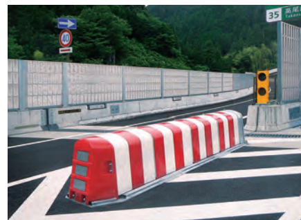
高速道路の衝突緩衝装置
