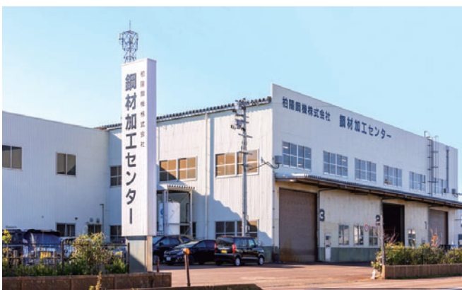
鋼材加工センター
