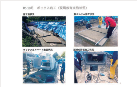
ボックス施工の現場教育実施状況
