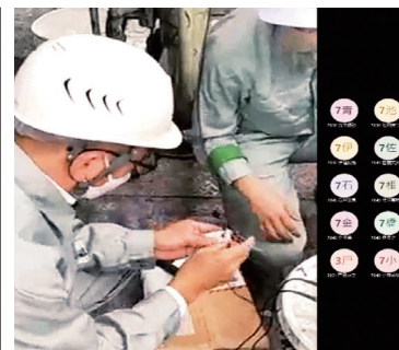
現場での回路設置
