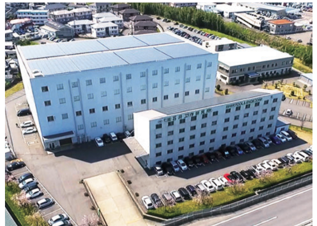
株式会社石井工作研究所 曲工場 全景
