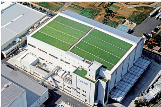
屋上緑化システム
